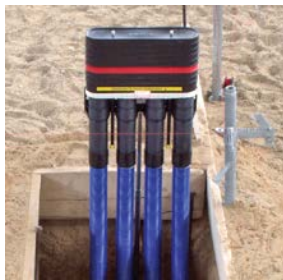
Bild 2 - zulässige Gebäudeeinführung Quelle: FHRK
