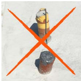
Bild 1 – falsch verwendetes KG-Rohr
